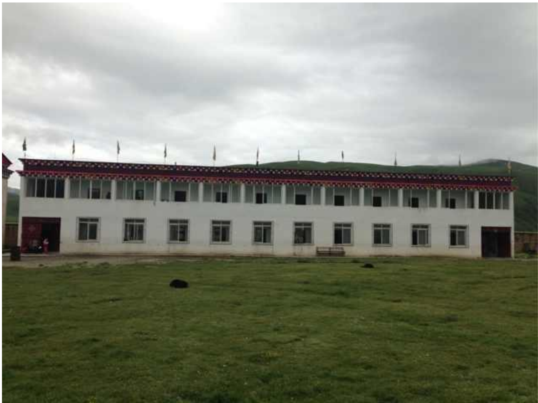
2011 年新建食堂一个，建筑面积 200 平米。（下图）
